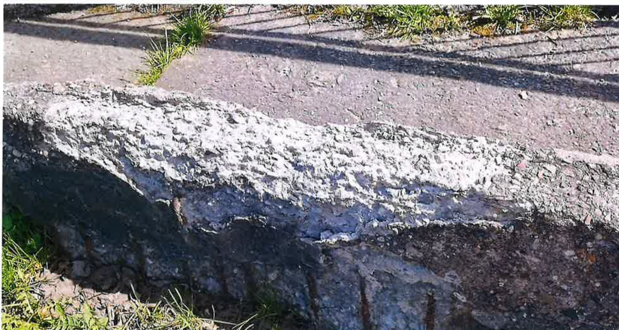
Betono gaminiu susidėvėjimas
